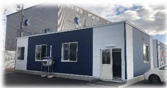
新築した会議棟
