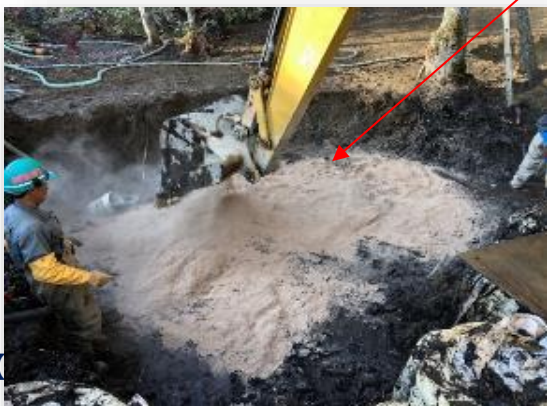
汚染現地にて汚染土に直接散布
