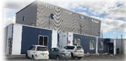
本社事務所外観
