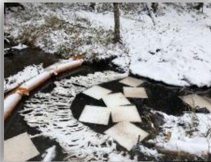
汚染範囲を拡大させないため、吸着マットを設置
