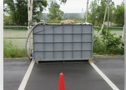
仮設分離槽を設置し、浄化後排水
