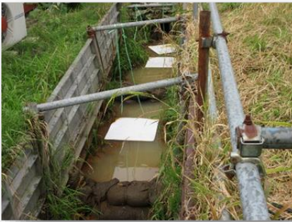
最終排水場所に吸着マットを設置し、日々監視
